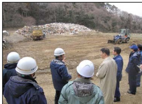
宮城県利府町 中倉廃棄物埋立処分場内 災害廃棄物仮置場
