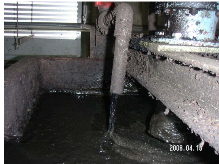
脱水機に高分子凝集剤 (ハイフロモックス) の投入
