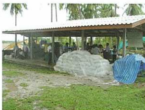
小学校の堆肥製造所
