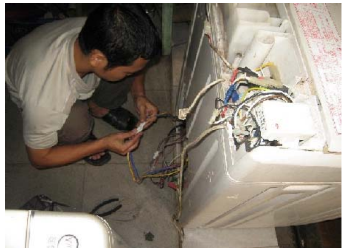
洗濯機の修理
