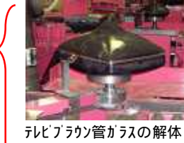
テレビブラウン管ガラスの解体
