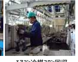
エアコン冷媒フロン回収
