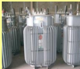
高圧トランス
