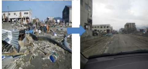
(石巻市内の災害廃棄物の撤去状況)
