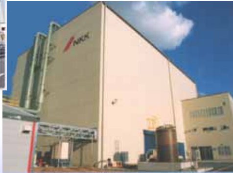
西日本製鉄所(福山地区)
