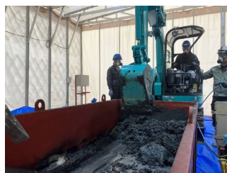
バックホウによる 固化剤等の混合試験
