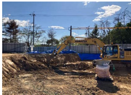
土壌掘削の様子
