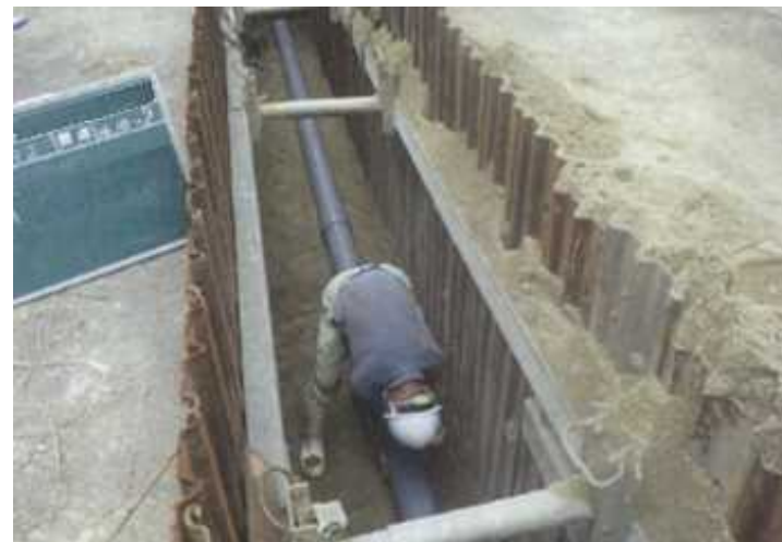
下水道管渠の布設（整備）状況
