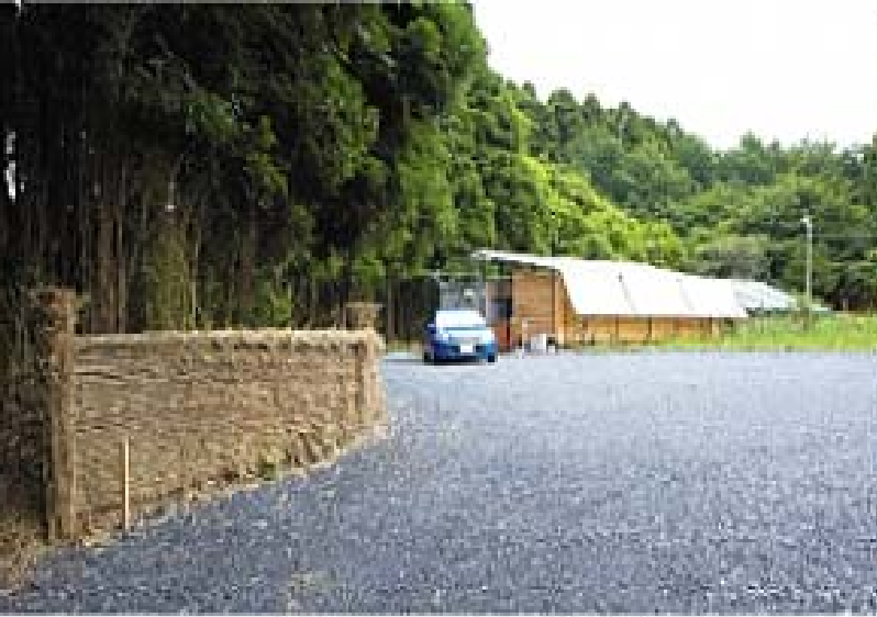
mignon東金シェルター駐車場
