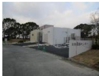
動物愛護センターの新築
