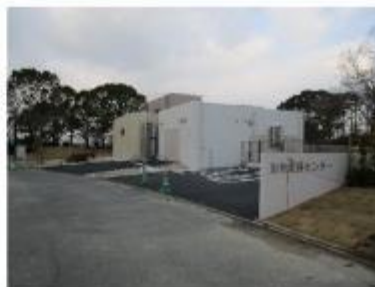
動物愛護センターの新築
