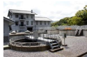
漁業集落排水施設
