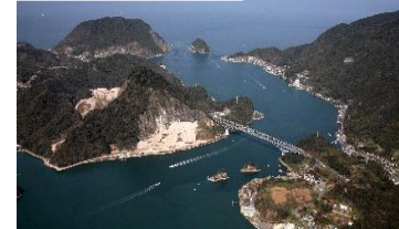
重要な構成要素の耐震対策工事 文化的景観「三角浦の文化的景観」 (熊本県宇城市)
