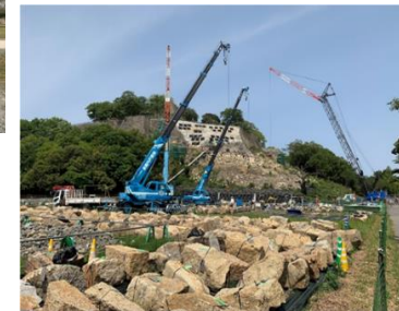
災害復旧工事の状況 (石垣石材分別作業) 史跡「丸亀城跡」 (香川県丸亀市)
