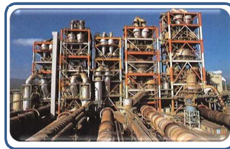
セメント製造施設(19施設)
