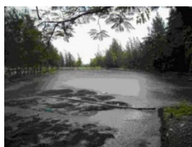
工場敷地内に広がる嫌気性オープンラグーン
