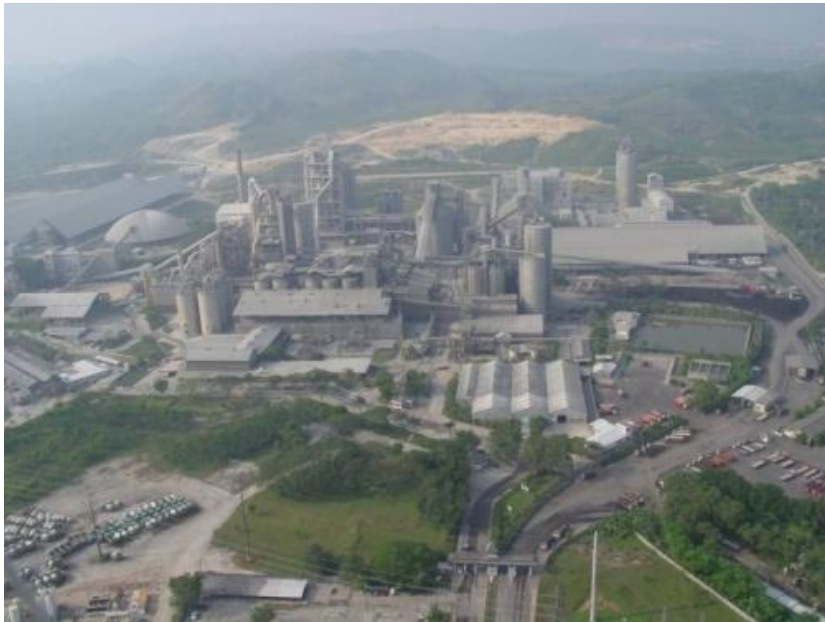
インドネシアのセメント工場
