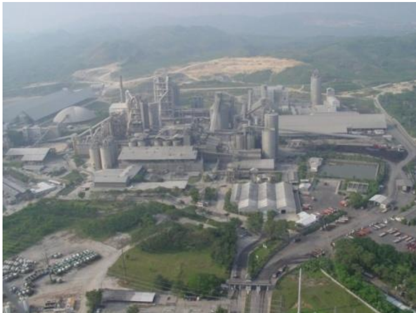
インドネシアのセメント工場
