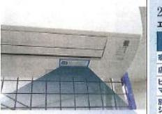
家庭用エアコンには最大でCO<sub>2</sub>（温暖化ガス）3,600kg（マルチシステムの場合は10,500kg）に相当するフロン類が封入されています。地球温暖化防止のため、移動・修理・廃棄等に当たってはフロン類の回収が必要です。
