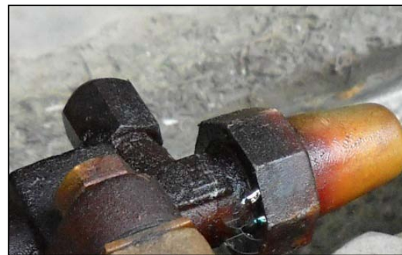
(写真)漏れ箇所
