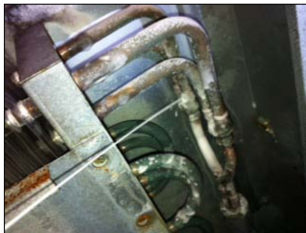
(写真)漏れ箇所
