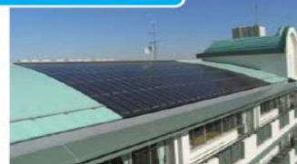
埼玉県和光市立新倉小学校
