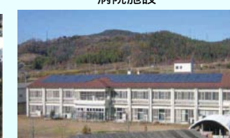
(岡山県・倉敷神経科病院) 40KW
