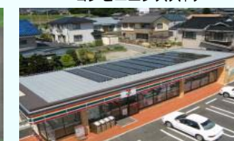
(長野県・セブン-イレブン 駒ヶ根上穂栄町店) 5.2KW
