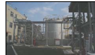
BDF製造設備
