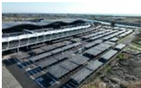
※仙台空港 再エネ発電合同会社提供
