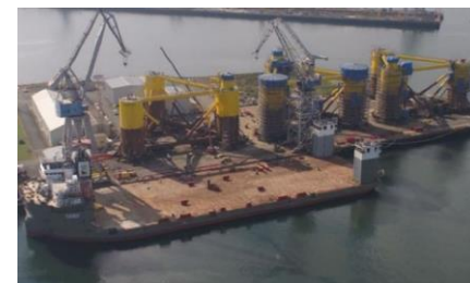
海外における浮体式洋上風力の基礎製造ヤード
