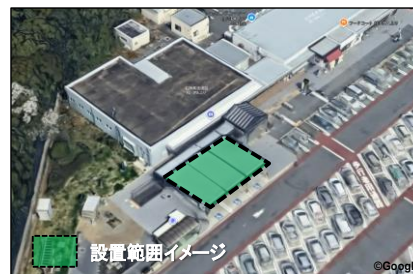
ペロブスカイト太陽電池設置予定箇所(遠景)
