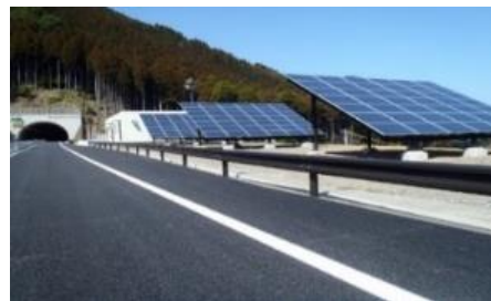
道路における太陽光発電の活用
