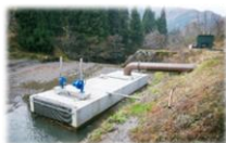
小水力発電施設
