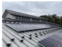
武道館における太陽光発電設備設置（福知山市）
