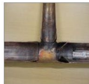
銅管を縦割り
