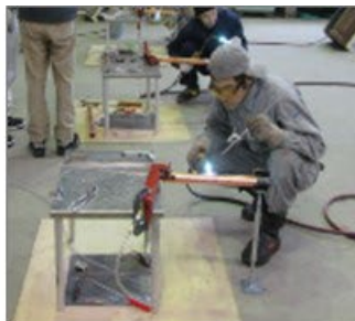
水平配管のろう付け
