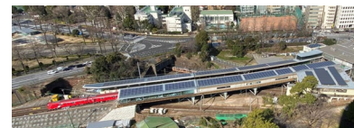
丸ノ内線四ツ谷駅(東京メトロ提供)
