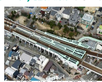
大物駅に導入された太陽光発電
