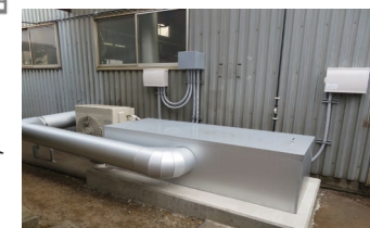
登録制度により設置された太陽光発電設備（上） 地中熱利用設備（下）
