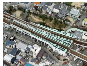
大物駅に導入された太陽光発電
