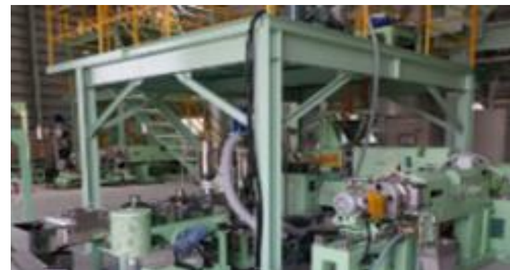
バイオマスプラスチック製造設備
