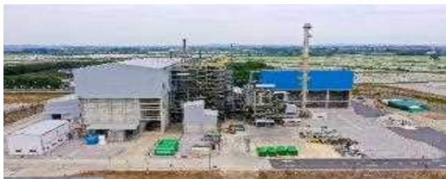
廃棄物発電（ベトナム）
