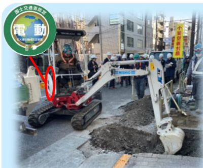
GX建設建機による施工
