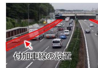
付加車線の設置 渋滞ボトルネック対策
