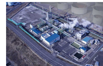
CO2分離・回収・貯留施設
