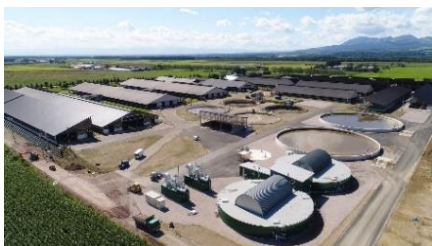
バイオガスプラント
