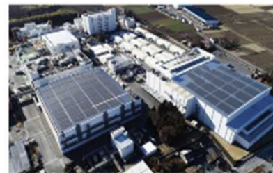
図1 栃木工場の太陽光発電設備（生産棟の屋上の様子）
