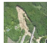
豪雨による大規模な山地災害
