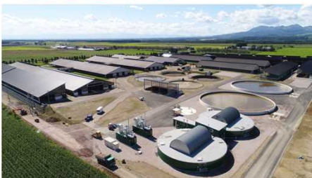
バイオガスプラント
