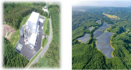
十文字チキンカンパー バイオマス発電所 軽米尊坊ソーラー
