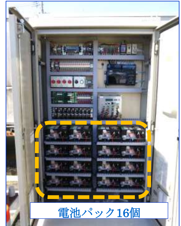
図1 設置した一次試作のソーラー街灯と蓄電池ボックスの内部
