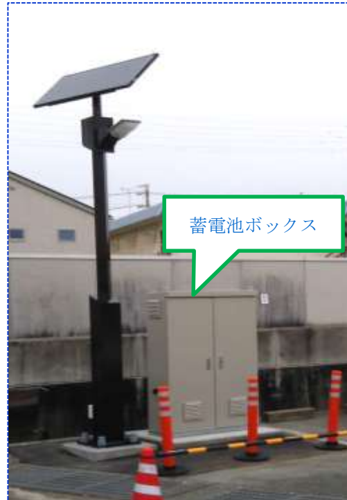
図1 設置した一次試作のソーラー街灯と蓄電池ボックスの内部
