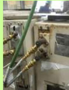
② カプラーをセットし、冷媒フロンを回収します。
