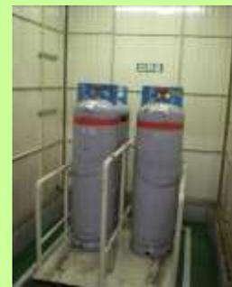
⑤ 保管庫では上下のチェーンによる転倒防止措置を行っています。
