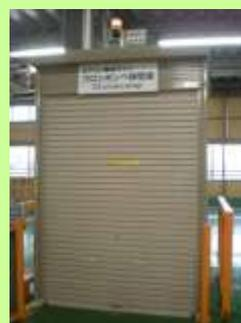
④ ポンベ保管庫(40℃以下)で保管。監視カメラと赤外線センサーで漏れの有無を確認します。
