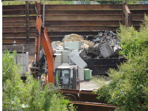
陸上のヤードで冷蔵庫を破壊
