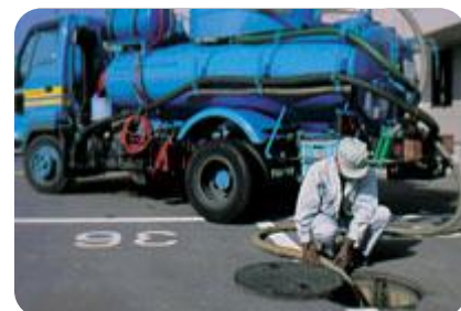
浄化槽の清掃
