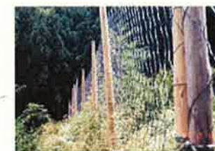
防護柵の設置
