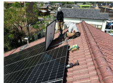
地元事業者による施工の様子
