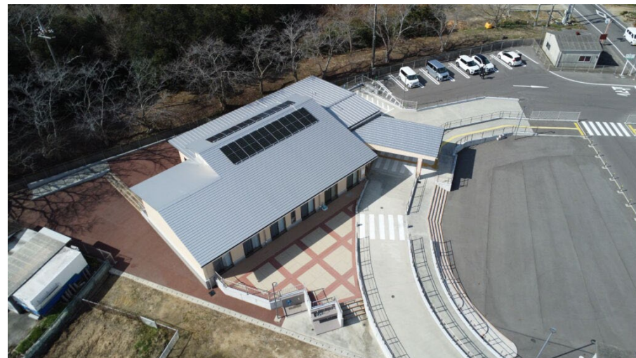
玉津コミュニティセンター発電所 災害時の停対策として太陽光発電併設型の蓄電池を併せて設置
