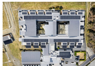
老人ホーム屋上（郡山市）への 自家消費型太陽光発電施設の導入支援 提供：福島県
