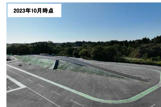
中間貯蔵施設内での道路盛土実証事業
