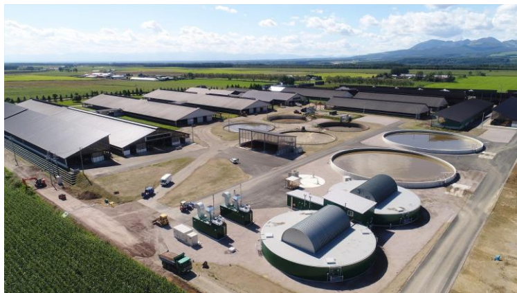
バイオガス発電設備
