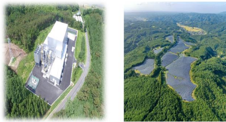
十文字チキンカンバー バイオマス発電所
