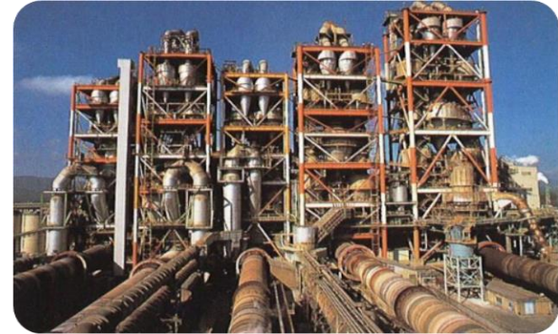
セメント製造施設
