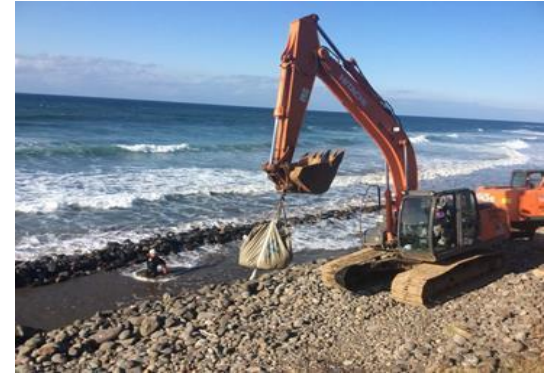
図：施工の様子（2014年10月）
