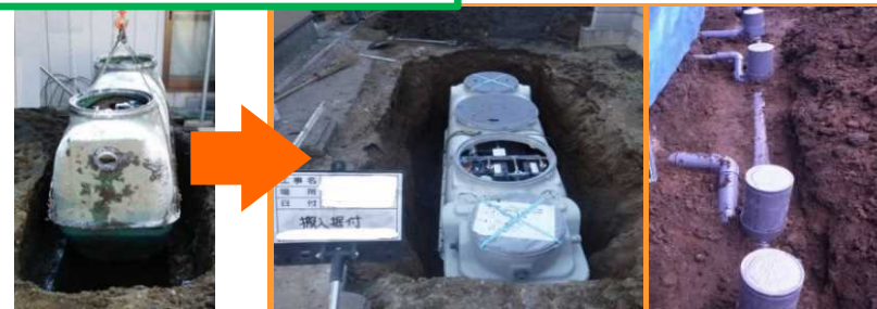
単独浄化槽撤去
